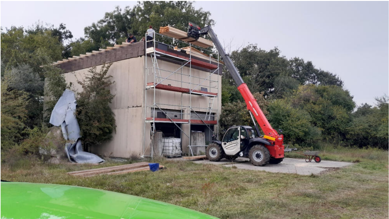
Abbildung 20: Umbauarbeiten für den Artenschutz im Hangar 5836 im Herbst 2024
